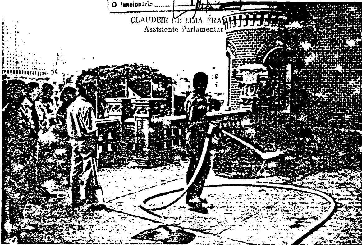
Teste da mangueira do hidrante do Salão Azul e verificação do caimento do piso do terraço.
