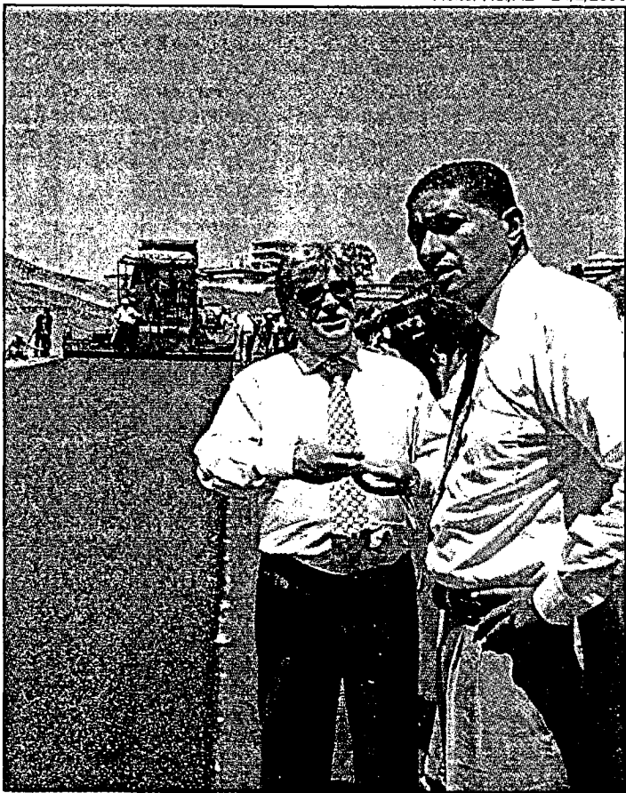
O prefeito Celso Pitta vistoria a nova pista de Interlagos
