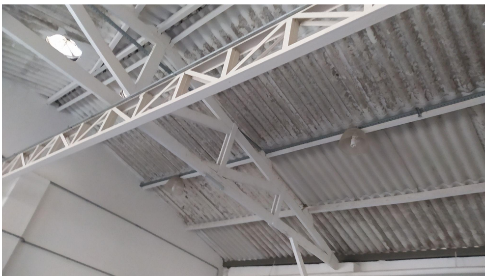
Figura 2: teto do galpão
