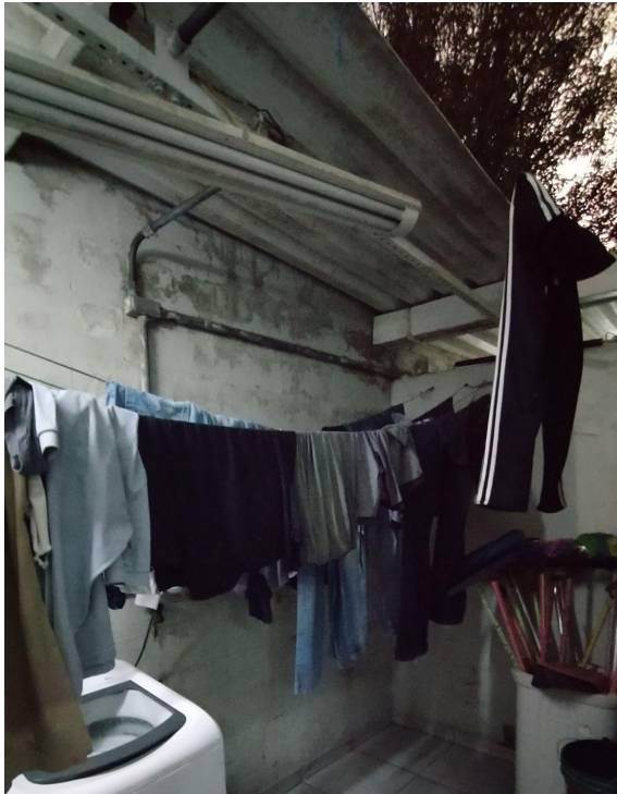
Figura 24: varal e teto semi descoberto
