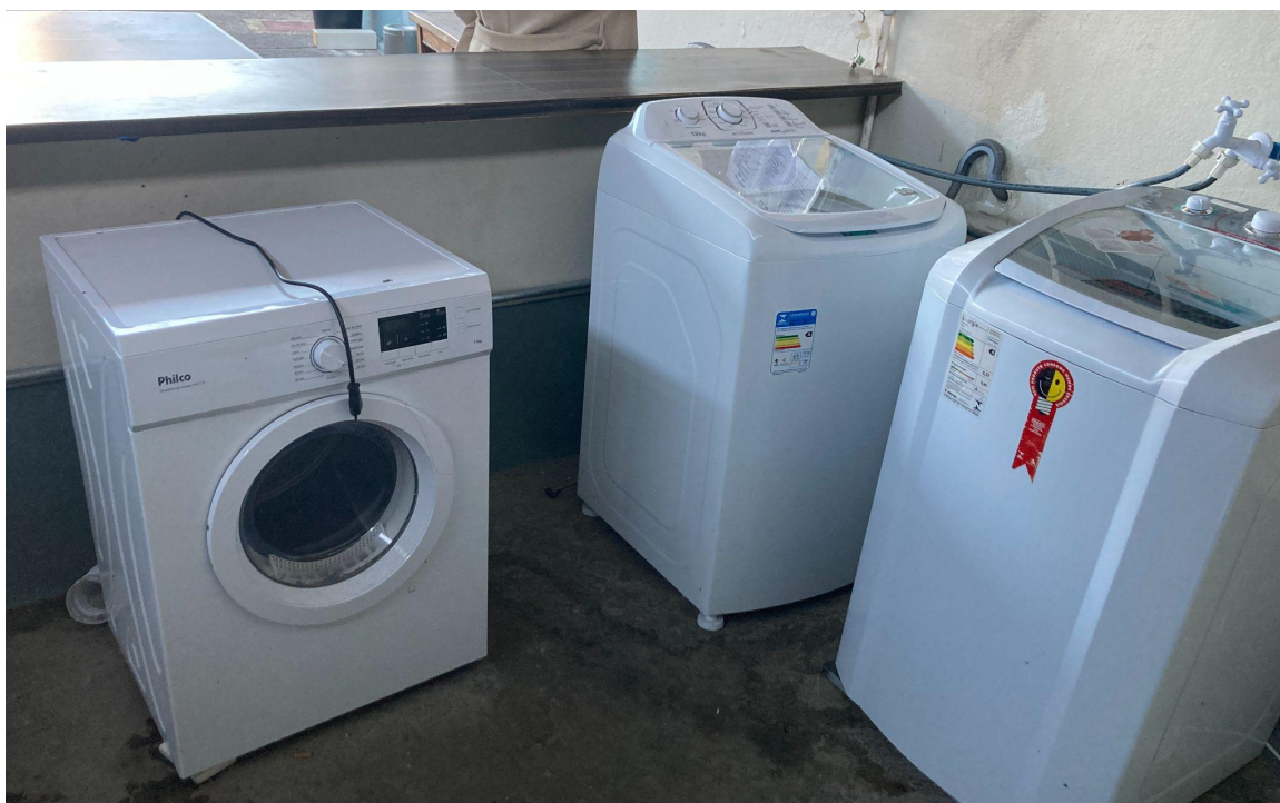
Figura 25: lavanderia - 2 máquinas de lavar e 1 de secar
