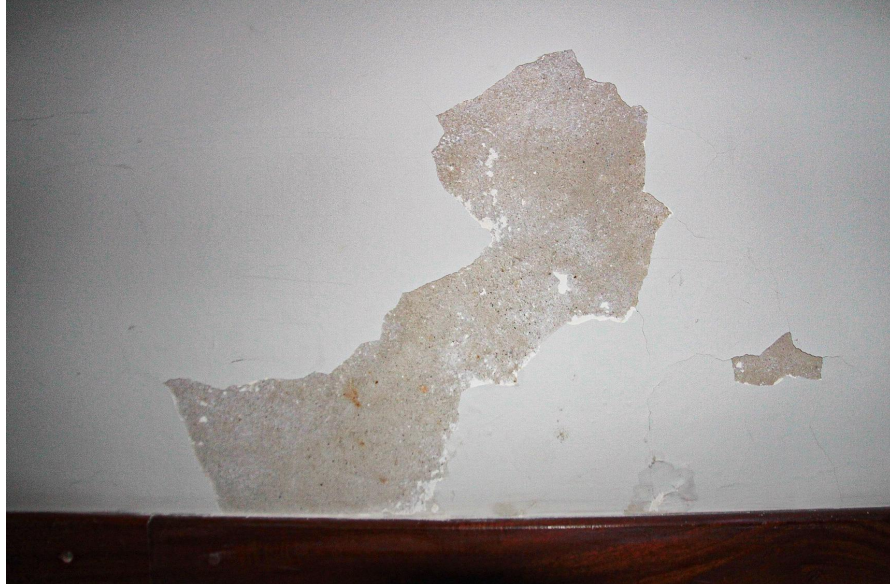
Figura 3: parede descascando
