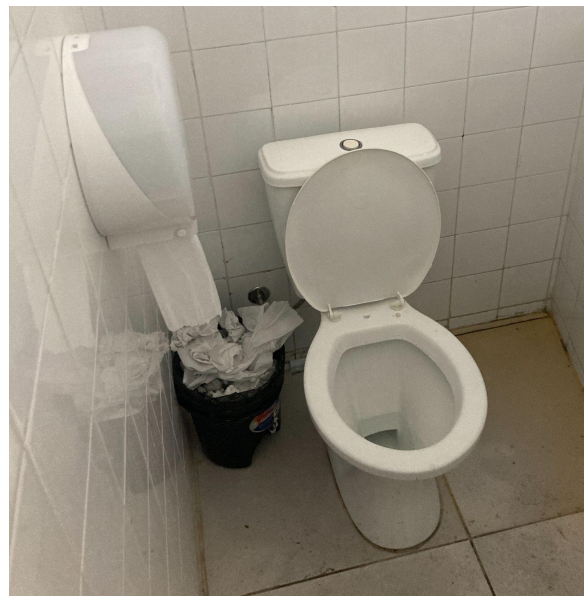
Figura 10: vaso sanitário sem assento
