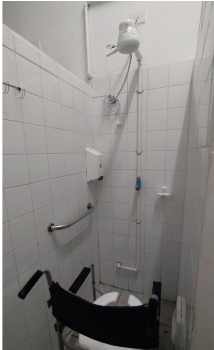
Figura 7: banheiro para PCD
