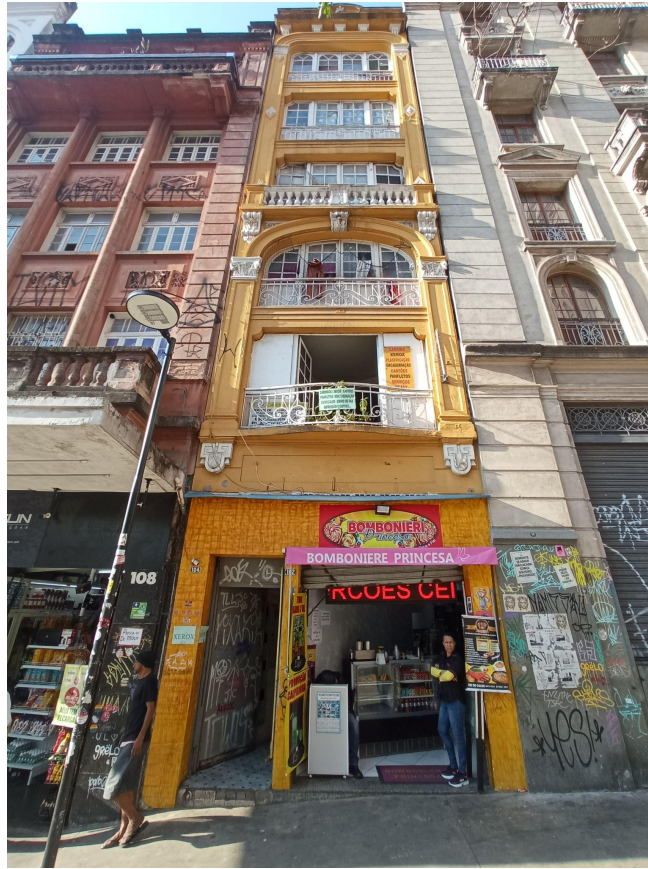
Figura 04: ao centro, fachada frontal do imóvel.
