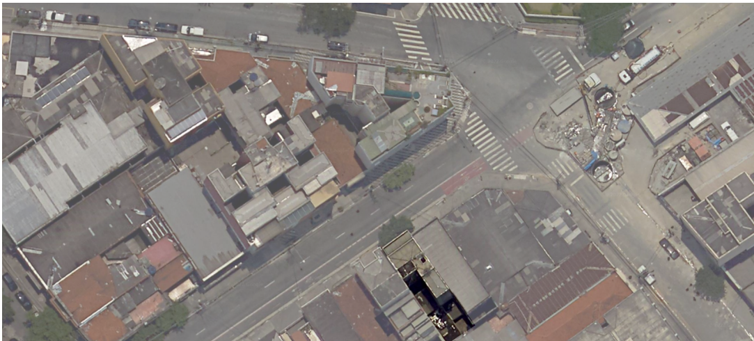
Figura 11: localização da edificação.. Fonte: produção própria a partir de imagem de satélite do Google Maps.
