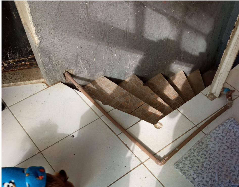
Figura 23: instalação de água e vista da escada.
