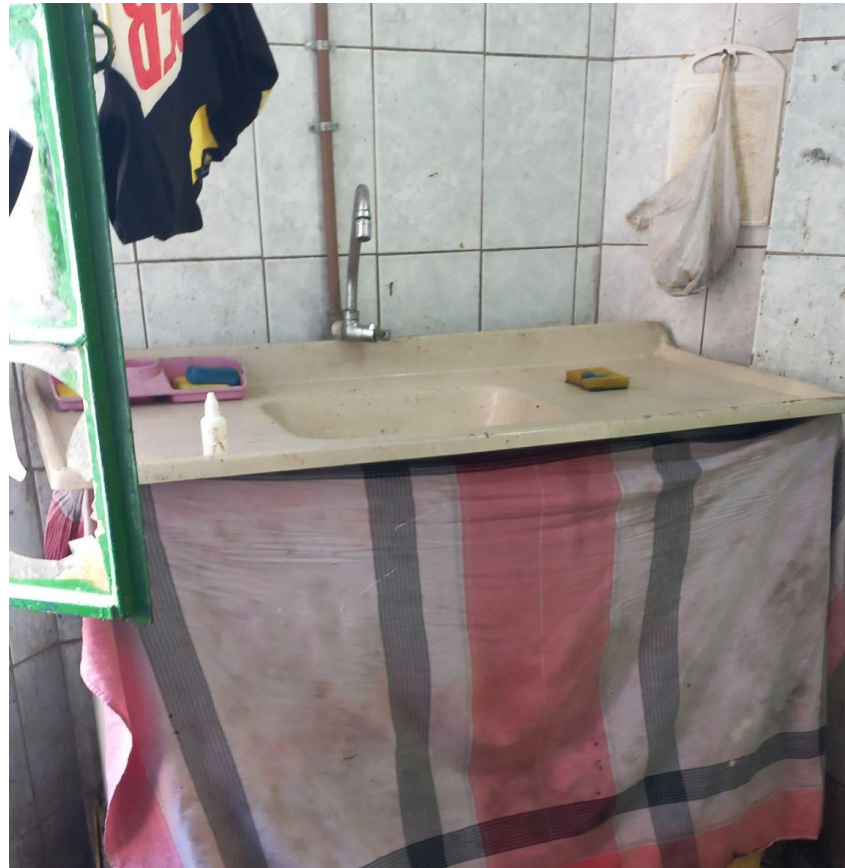
Figura 31: pia instalada na parte externa da unidade, com espaço para instalação do fogão.
