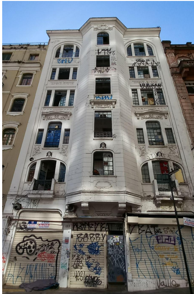
Figura 19: ao centro, fachada frontal do imóvel.
