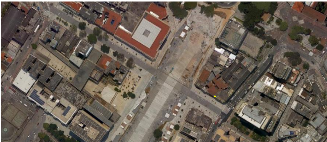
Figura 02: localização da edificação, junto ao Vale do Anhangabaú. Fonte: imagem de satélite do Google Maps.
