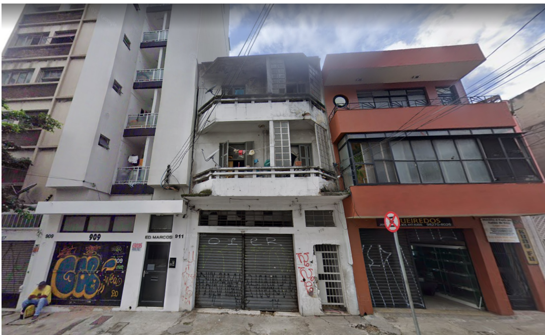
Figura 12: ao centro, fachada do imóvel. Fonte: imagem do Google Street View
