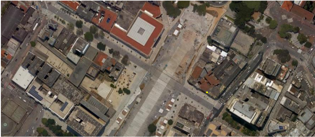
Figura 17: localização da edificação, junto ao Vale do Anhangabaú. Fonte: imagem de satélite do Google Maps.
