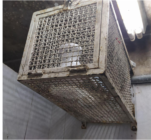
Figura 11: chuveiro com grade
