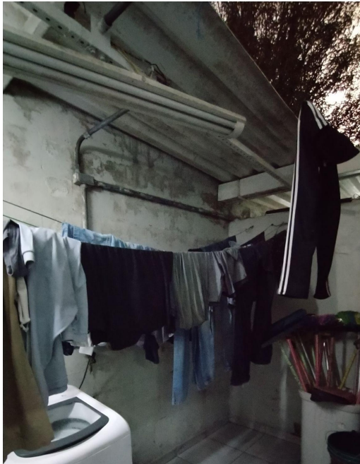
Figura 24: varal e teto semi descoberto
