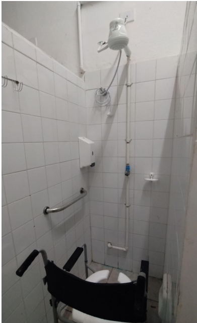
Figura 7: banheiro para PCD
