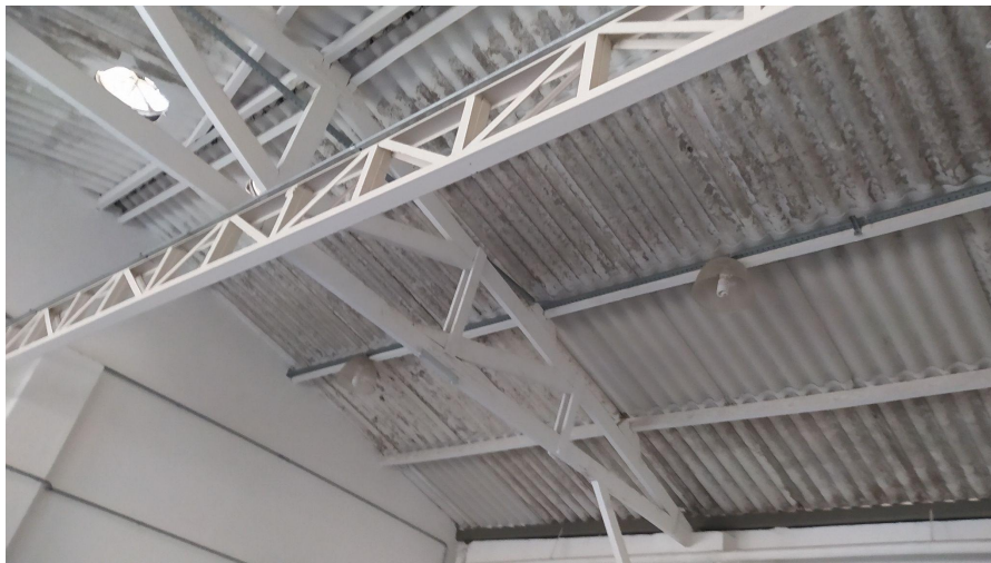
Figura 2: teto do galpão
