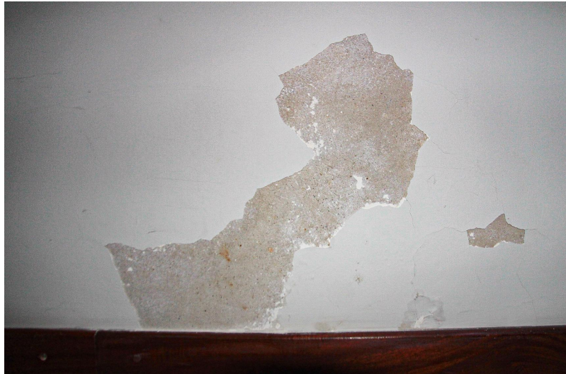
Figura 3: parede descascando
